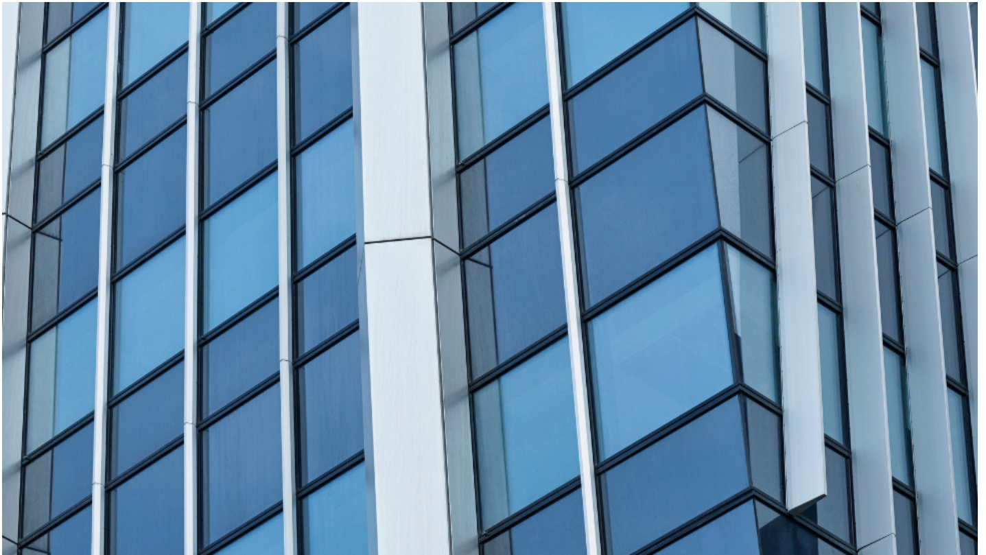
Kantoorgebouw met COOL-LITE SKN 165 | Saint-Gobain Building Glass
